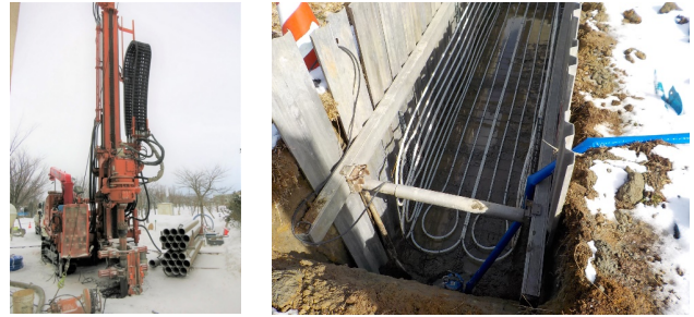
写真-1 各採熱方式の埋設風景
