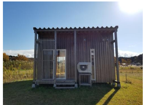
写真-1 対象建物外観 (応急仮設住宅)
