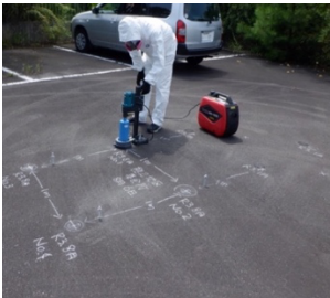
図-2 調査地点でのコア抜き
