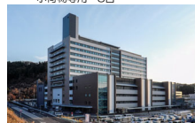
建屋外観写真
