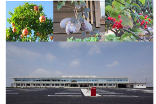
一須賀川信用金庫本館一
