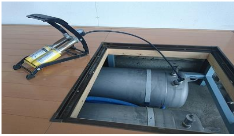
図-10 断水時の給水タンクにエアポンプ接続
