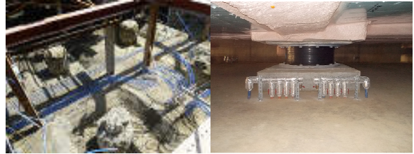
写真-4 水平敷設
