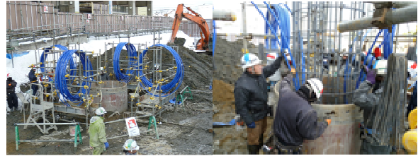
写真-2 作業台設置
