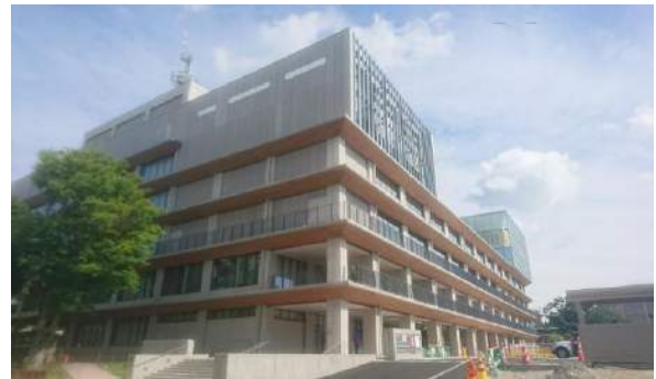
写真-1 建物外観
