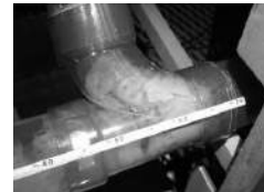
写真3 搬送水1回目投入後(大便器3-④)
