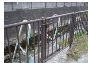
図9 No. 48の入口扉と施錠
