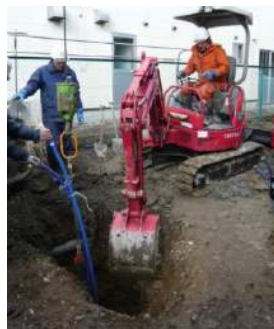
写真-5 熱交換器設置 写真-6 埋設作業
