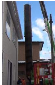
写真-3 建柱車による掘削 写真-4 さや管設置
