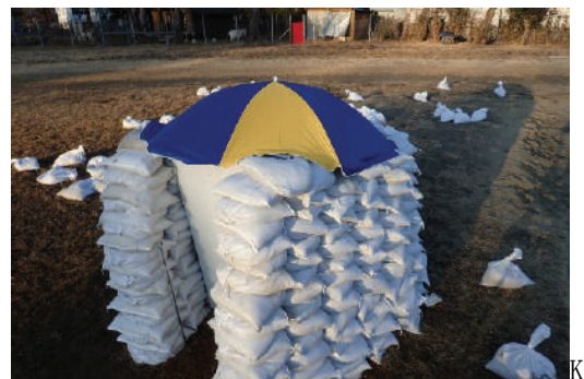
図-4 完成したアースバッグハウス
