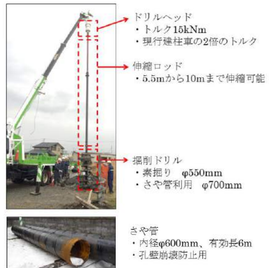
写真-1 開発した主な掘削機材
