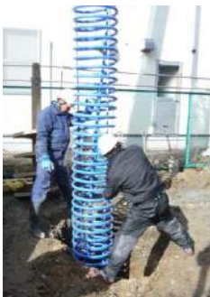
写真-5 熱交換器設置 写真-6 埋設作業
