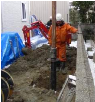
写真-3 建柱車による掘削 写真-4 さや管設置
