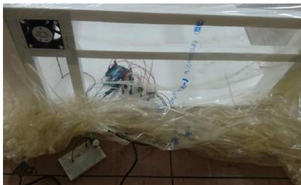
写真-3 センサー及びファン設置後の様子
