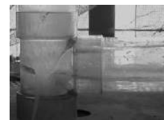
写真2 2階排水立て管合流部
