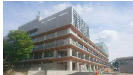
図-1 調査建物外観写真
