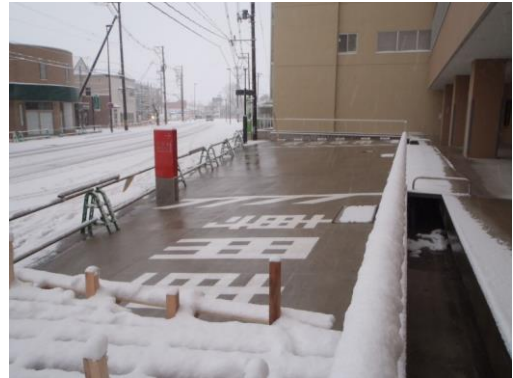
写真-1 融雪システム導入後の駐車場(系統①)
