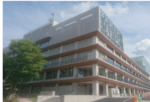
写真-1 対象建物外観 表-1 秋田市庁舎の建物概要
