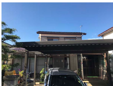
写真-2 A邸外観写真
