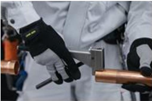
写真-3 窒素ガス封入口の穴あけ
