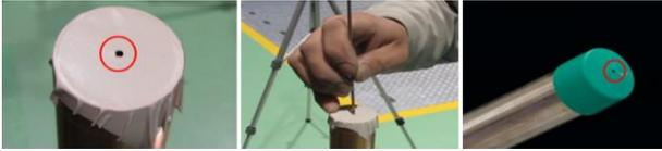
写真-2 管端閉止と逃口開口の設置
