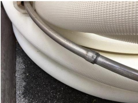
写真-1 アルミ冷媒配管
