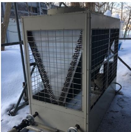
図-2 空気-水熱交換器の外観
